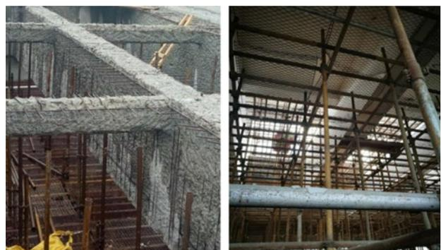
a-板拆除后 b-新浇板
