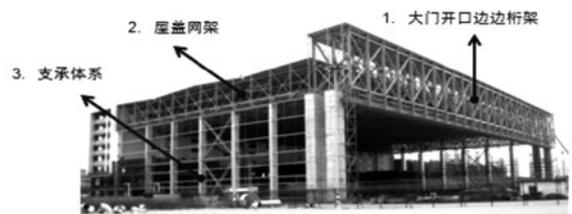
图1 空间网架+大门桁架屋盖结构体系
