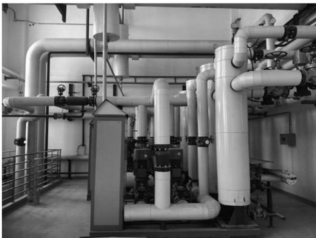
图3 项目换热站管道施工完成图
