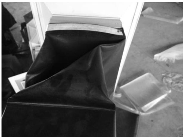
图2 风管软接头和风管密封不严
