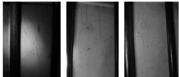
图16 变截面位置塔筒内壁裂缝
