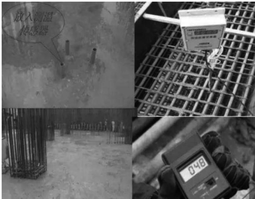
图 大体积混凝土温度控制图
