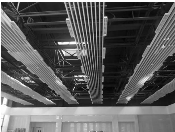
图4 餐厅风机盘管施工完成图
