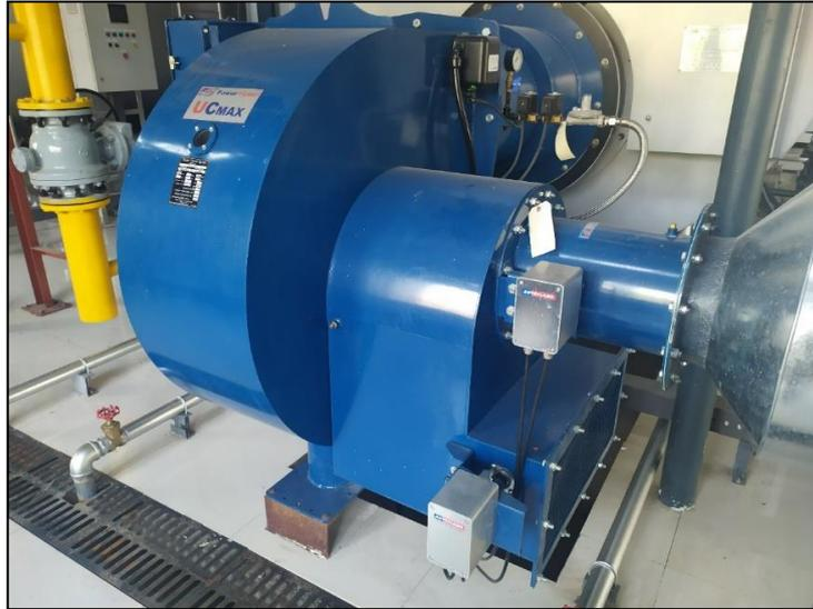
图 4-2 锅炉低氮燃烧器
